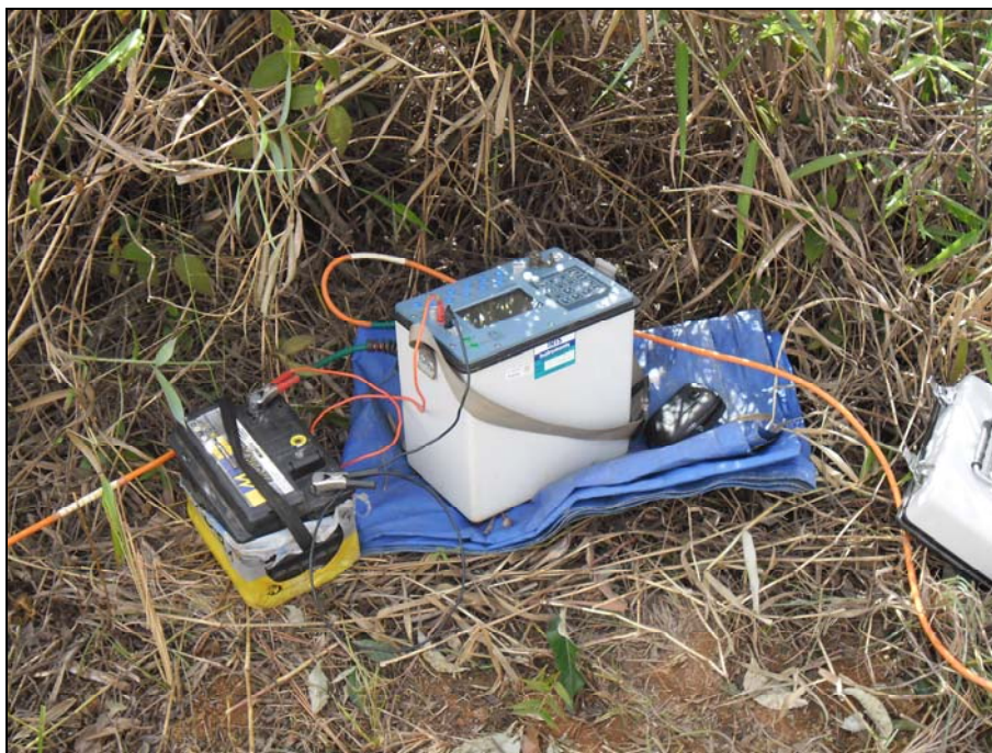
Figura 3.6 - Equipamento de aquisição de dados geoeletricos SYSCAL PRO de 48 canais conectado aos cabos multieletrodos e à bateria.
